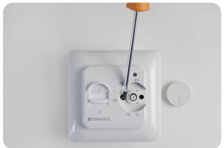
Temperaturregler mit demontiertem Knopf
